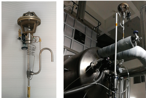
(a) 美国PHPK公司机械式自动排气阀 (b) 机械式自动排气阀应用场景
